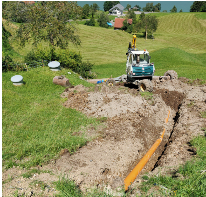
Vorsichtiger Neubau Entwässerungsleitung bei der Quelle Ebnet (Späzeren)
