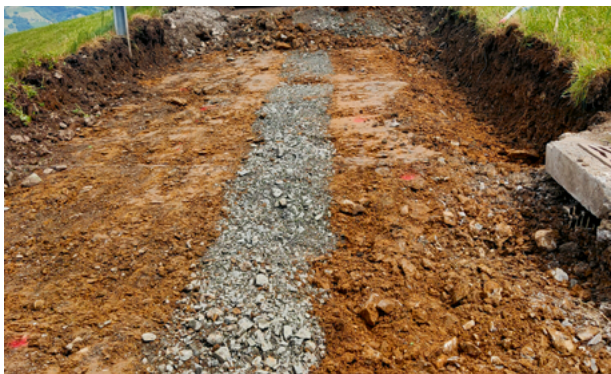
Situation Kofferrung – Richtung Langberg Kofferrung nur in der Mitte vorhanden
