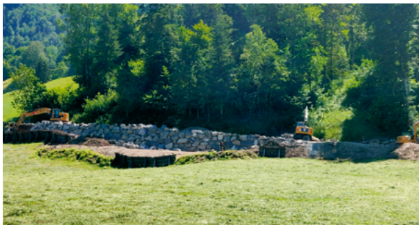
Ersatz Blocksteinmauer Späzeren
