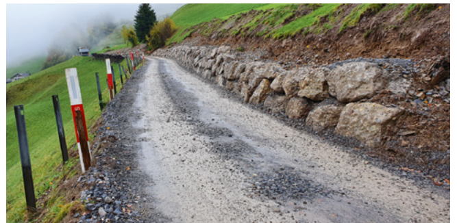
Komplettersatz innerhalb Quellschutzzone
